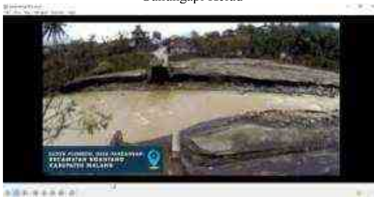
Gambar 8. Kerusakan pasca erupsi Gunungapi Kelud
