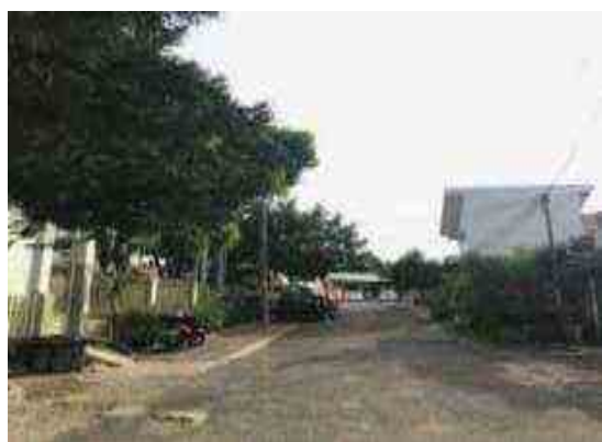
Gambar 6 Kondisi Jalan Situ Rawagedeh
